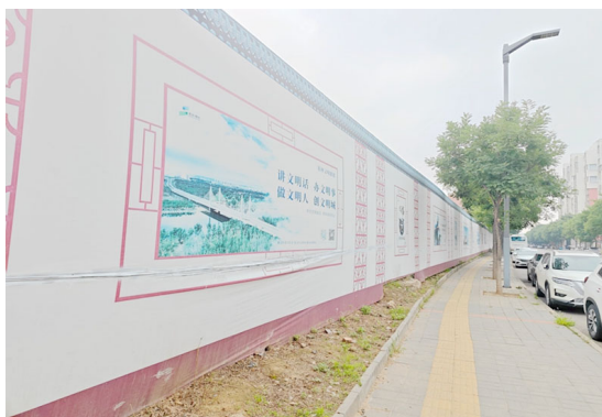
项目北侧围挡
